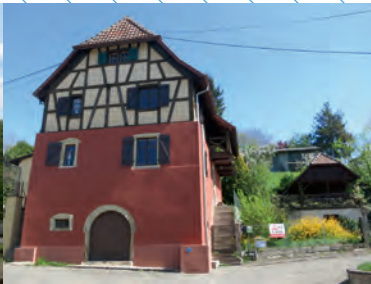
Maison vigneronne du 17 e siècle
